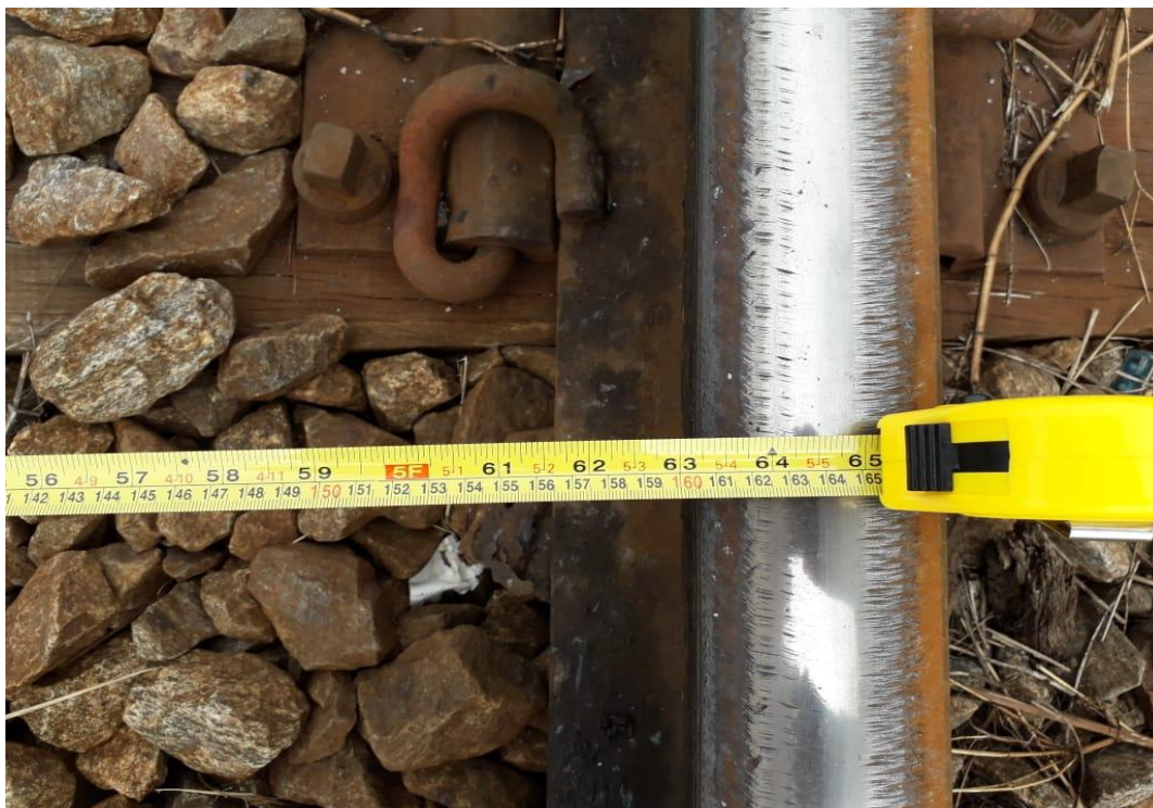
Figura 4: Medidas do comprimento da via férrea de bitola larga na cidade de Três Rios (RJ), localizada na região Centro-sul fluminense. Fonte: Autoria própria.
