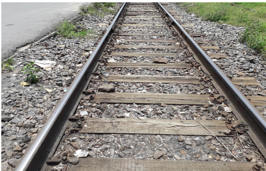
Figura 1: Via férrea de bitola larga na cidade de Três Rios (RJ), localizada na região Centro-sul fluminense.
