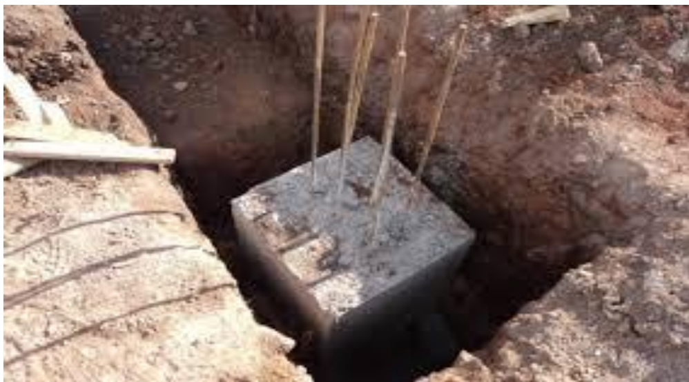
Figura 05. Exemplificação de blocos de fundação. Fonte: Desconhecida.
