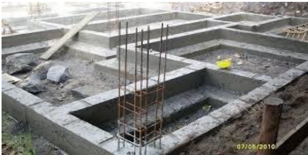
Figura 01: Exemplificação de sapata corrida. Fonte: Desconhecida.
