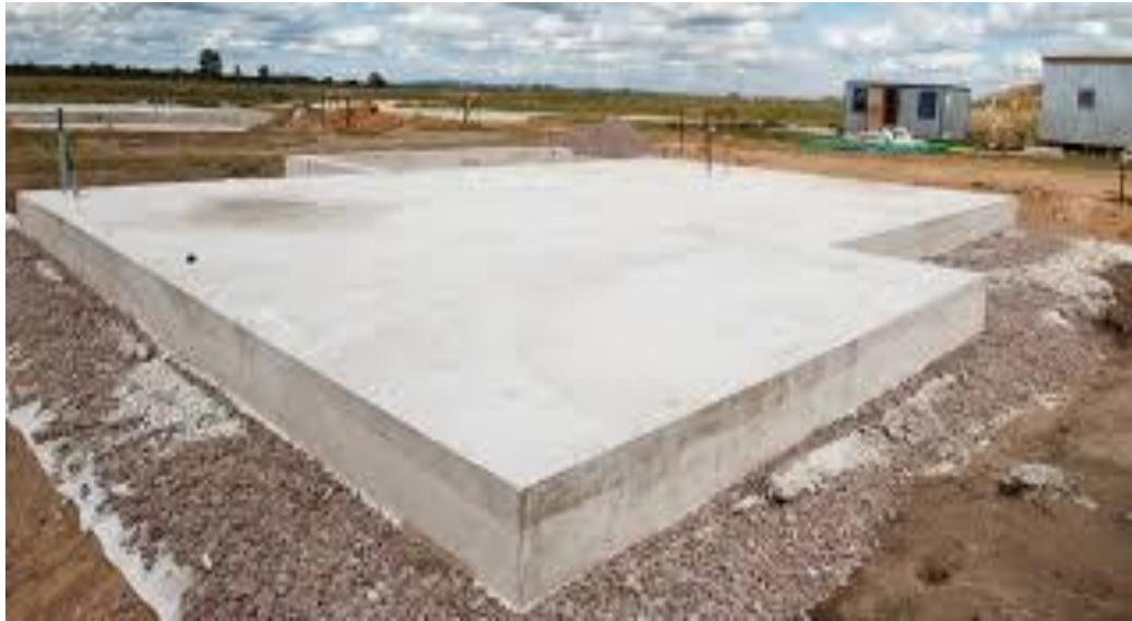
Figura 04. Exemplificação de radier. Fonte: Desconhecida.
