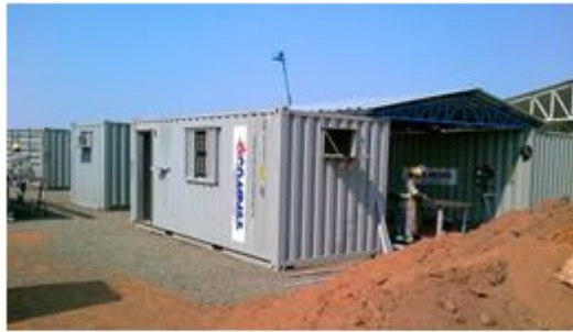
Escritório em canteiro de obras
