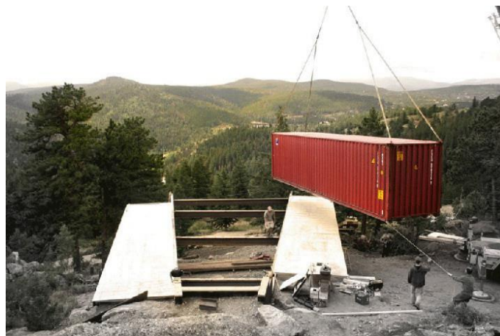
Fundação para o posicionamento do contêiner Fonte: Correio Brasiliense (2020)
