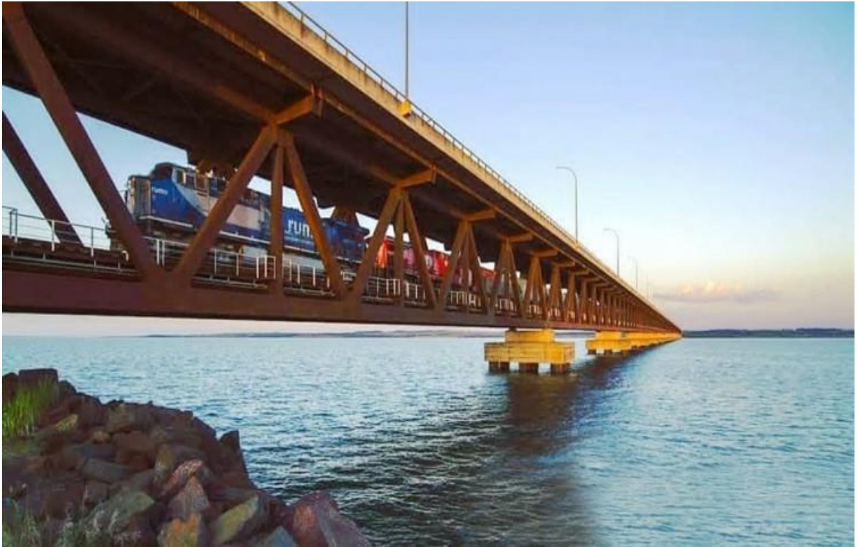
Figura 5: Ponte rodoferroviária sobre o rio Paraná, localizada nos estados de Mato Grosso do Sul e São Paulo.
