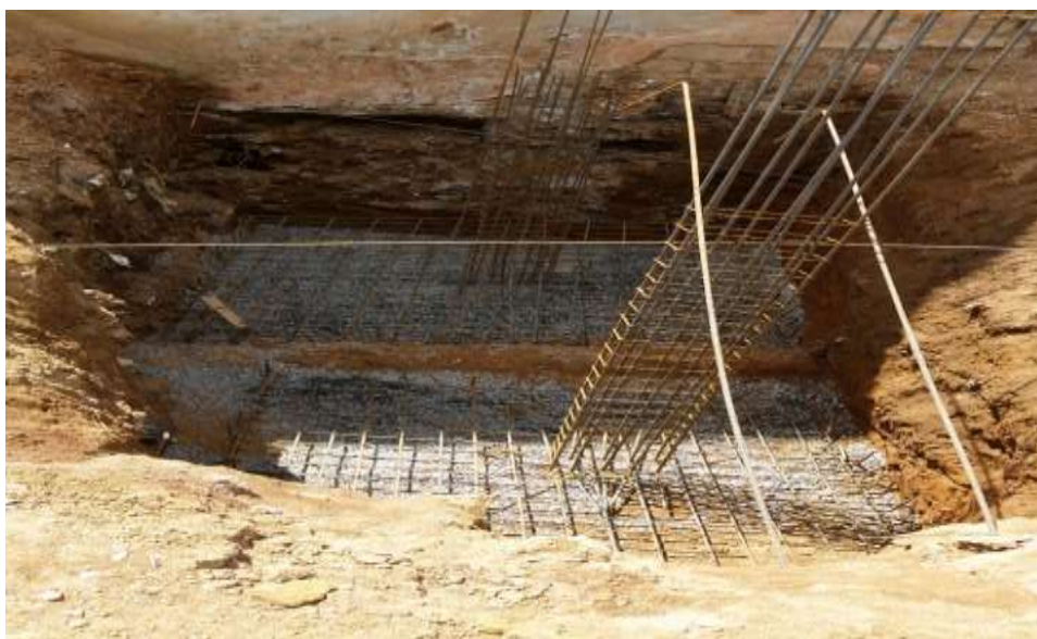
Imagem 2: Concretagem da sapata.
