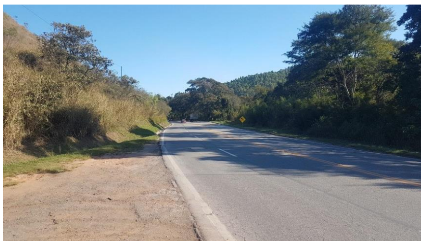
Imagem 1 - Situação atual – Vista sentido Rio de Janeiro
