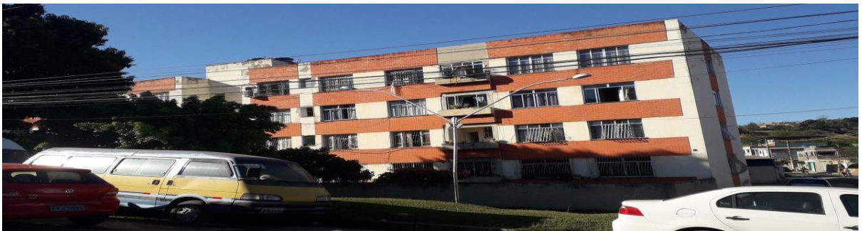
Figura 1: Conjunto Habitacional Purys. Fonte: Processo 12734/19
