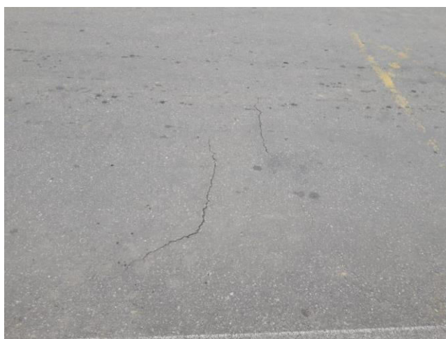
Figura 4 – Trinca longitudinal encontrada na Avenida Bento Gonçalves Pereira, Paraíba do Sul.
