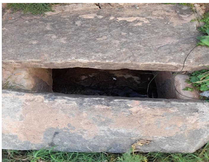
Figura 2: Foto do Bueiro no Bairro Várzea do Otorino
