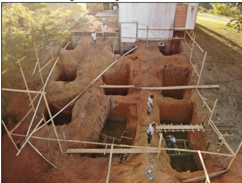
Figura 3 – Imagem aérea da obra
