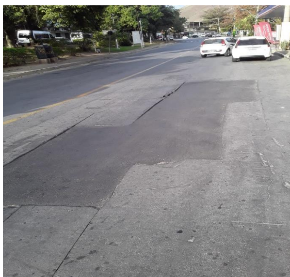
Figura 8: Concreto asfáltico empregado no local
