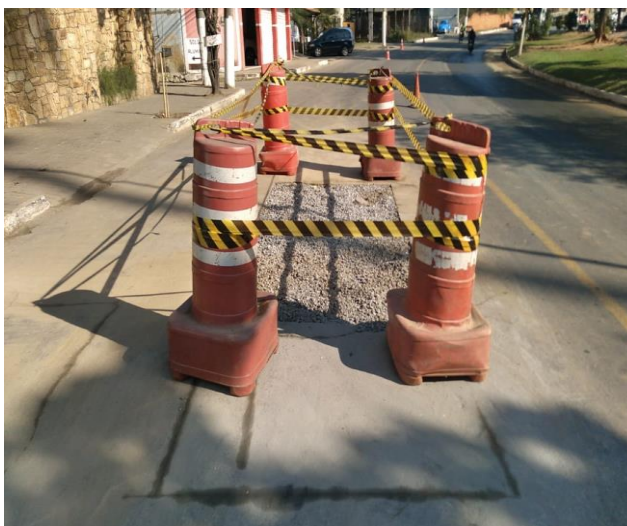
Figura 7: Preparação para pavimentação.
