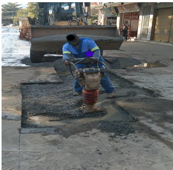
Figura 6: Compactação com sapo mecânico
