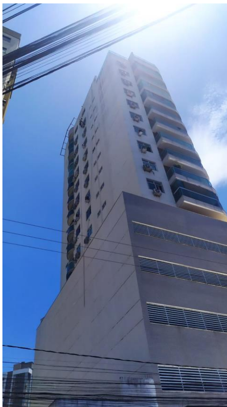
Figura 3: Vista da Edificação
