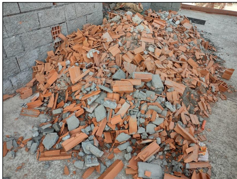
Figura 1: Acúmulo de RCC em obra: resíduos de concreto, tijolos e argamassa descartados.
